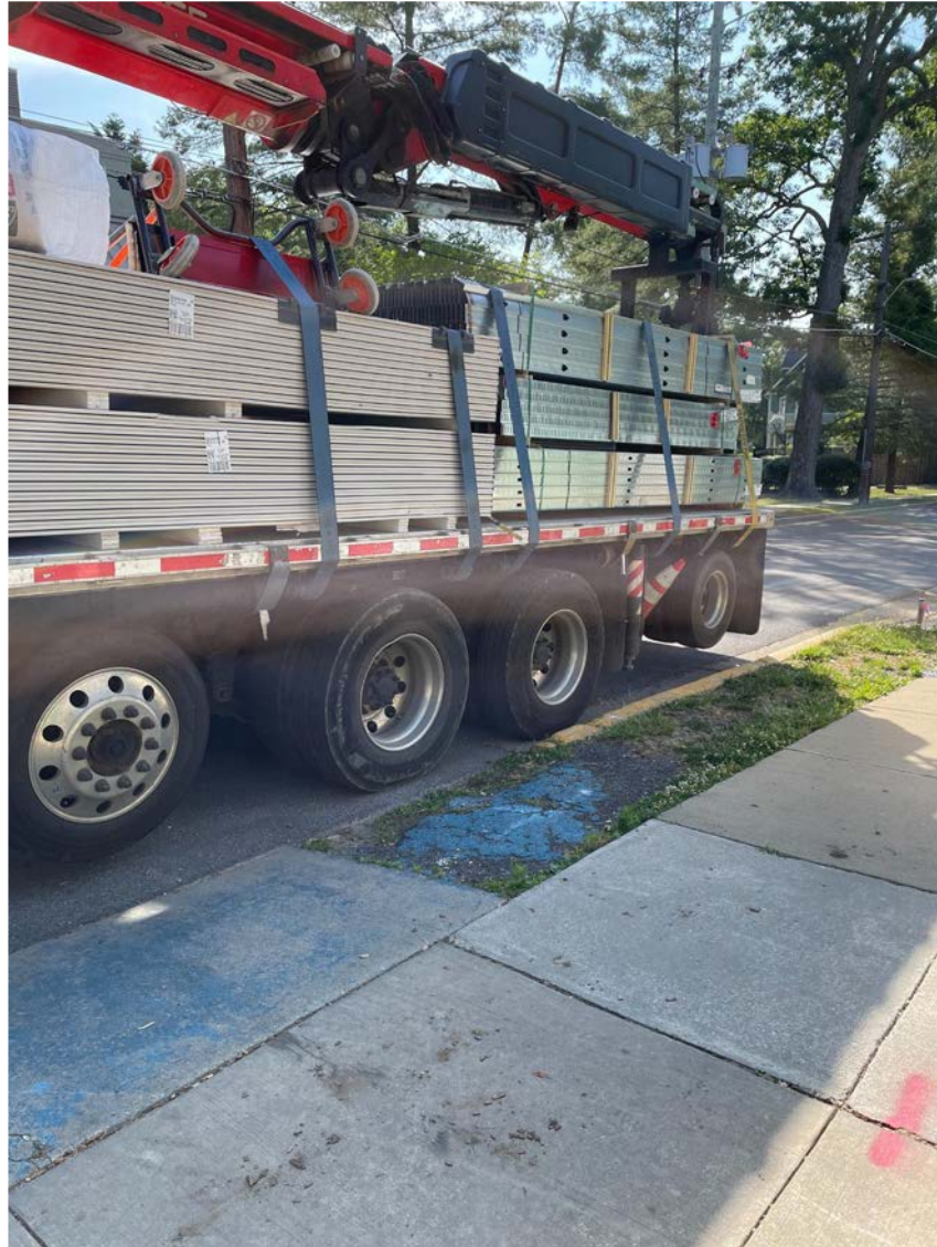
DRYWALL AND STUD DELIVERY
